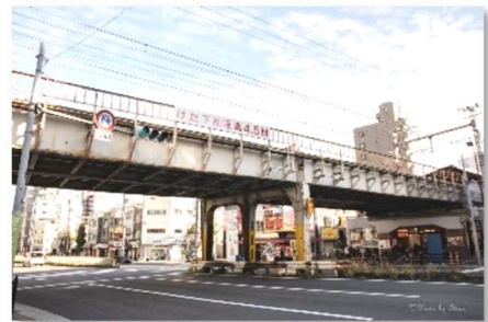
JR 環状線玉造駅高架橋
