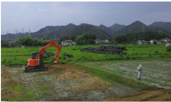
福島県の除染作業は終わることがない
