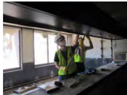
被災したホテルの片付けをする 釜石ベースのボランティアさん (2011年7月)
